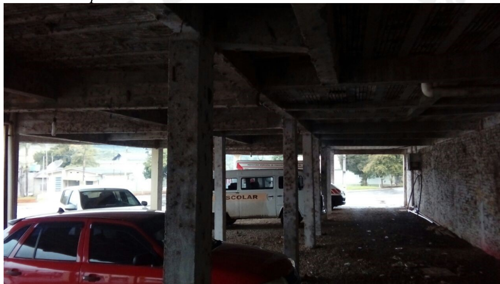
Foto 1: Vista interna pavimento térreo que será concluído
